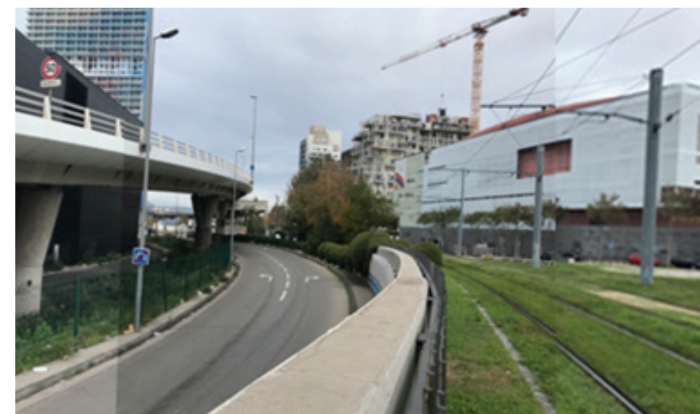
Le A55(Viaduc de Storione) , sortie tunnel, lignes de tram, boulevard de Paris
